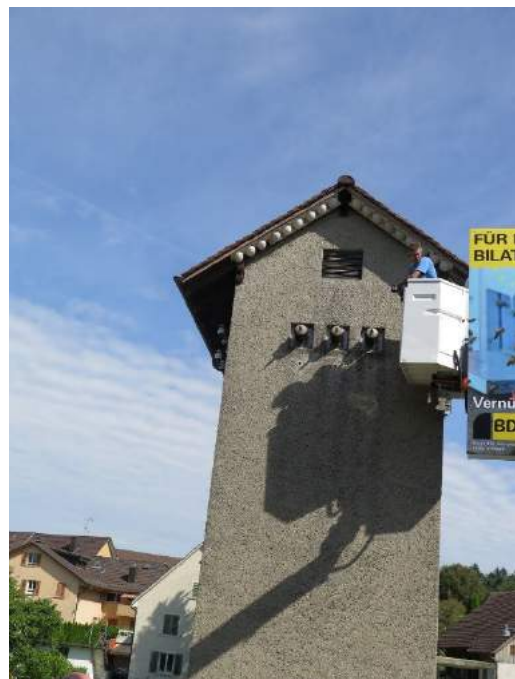
Nisthilfen am alten Trafoturm, Quartier Rütihof, Baden
